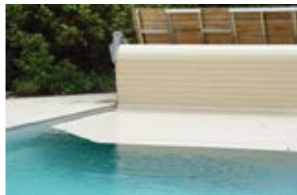
L'axe motorisé est amené automatiquement à l'aplomb du bassin et le tablier peut se dérouler pour une sécurisation totale du bassin en toute simplicité.
