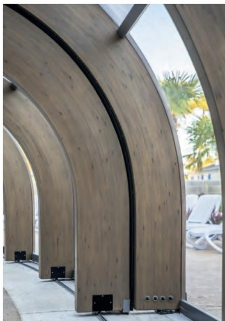
Le système de roulement à la base de la coupole
